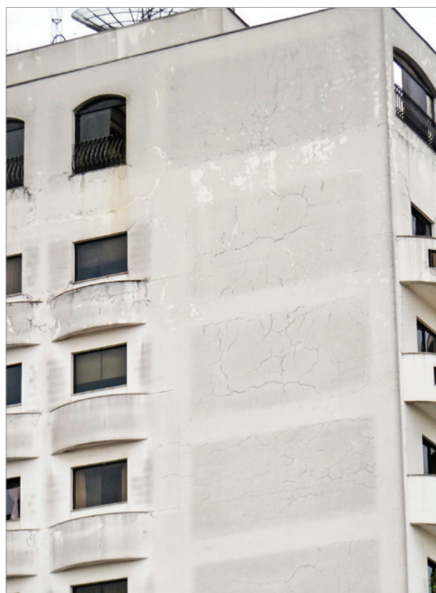
Foto 1 – Deficiência de manutenção em fachadas pintadas – Fase U do PPEEU
