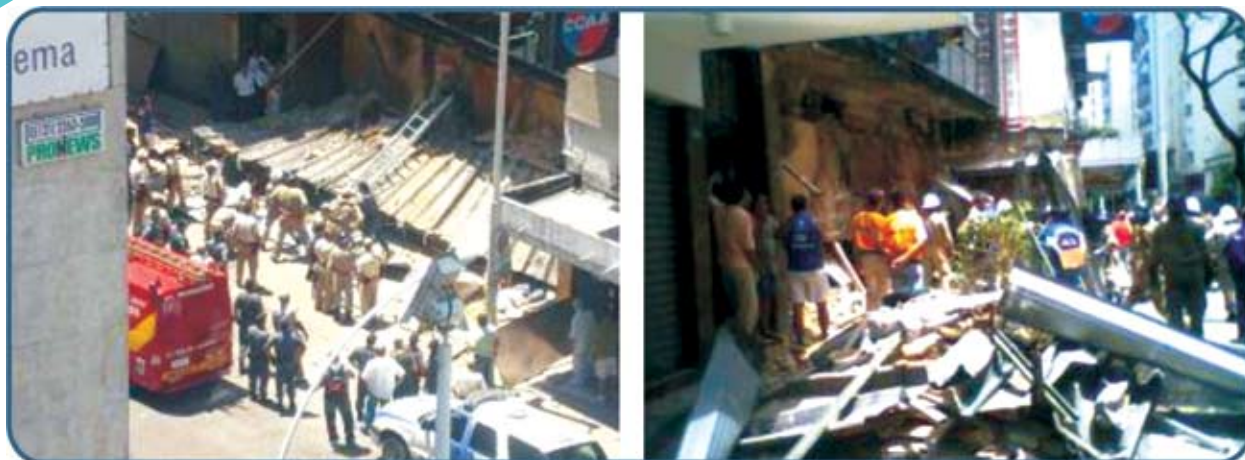
Figura 1 – Foto da queda da marquise do Hotel Canadá no Rio de Janeiro
